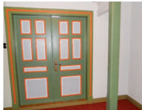
Den gamle døra innvendig.
