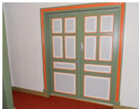
Den nye døra innvendig.
