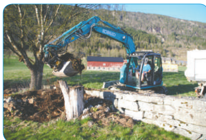
Håvard Lyslo dreiv med gravemaskin. Foto: Geir-Ståle Vatnamo
